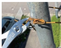
각종 시공 작업
