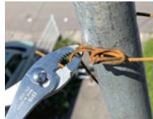
각종 시공 작업 시 유용
