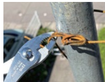
각종 시공 작업 시 유용
